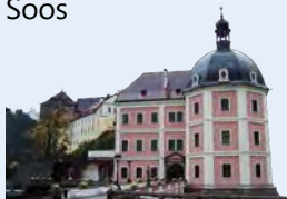
Bečov nad Teplou
